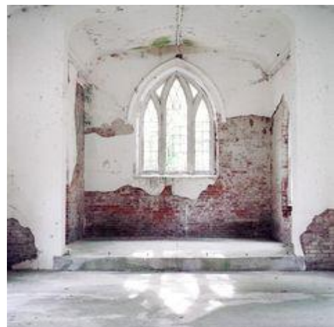
Wysoko zawilgocone ściany
