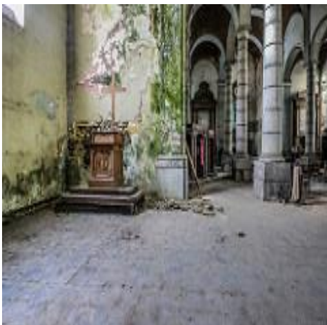
Porosty powstałe na ścianach
