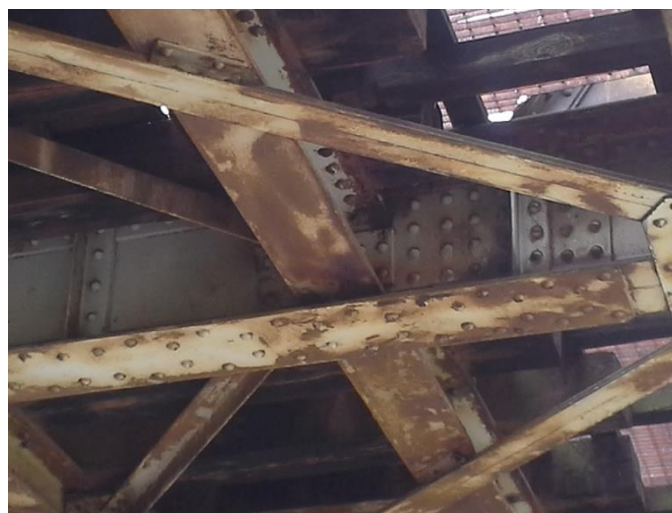
Fig 2. Oryginalny stan konstrukcji
