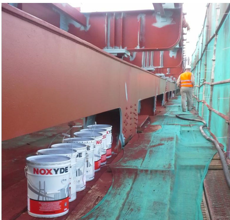
Zdj. 4 konstrukcja w czasie aplikacji powłoki Noxyde
