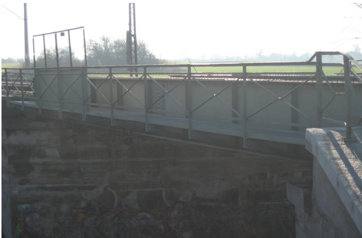
Zdjęcie 4. . Most kolejowy Opole ul. Głogowska –stan powłok 8 lat od aplikacji.
