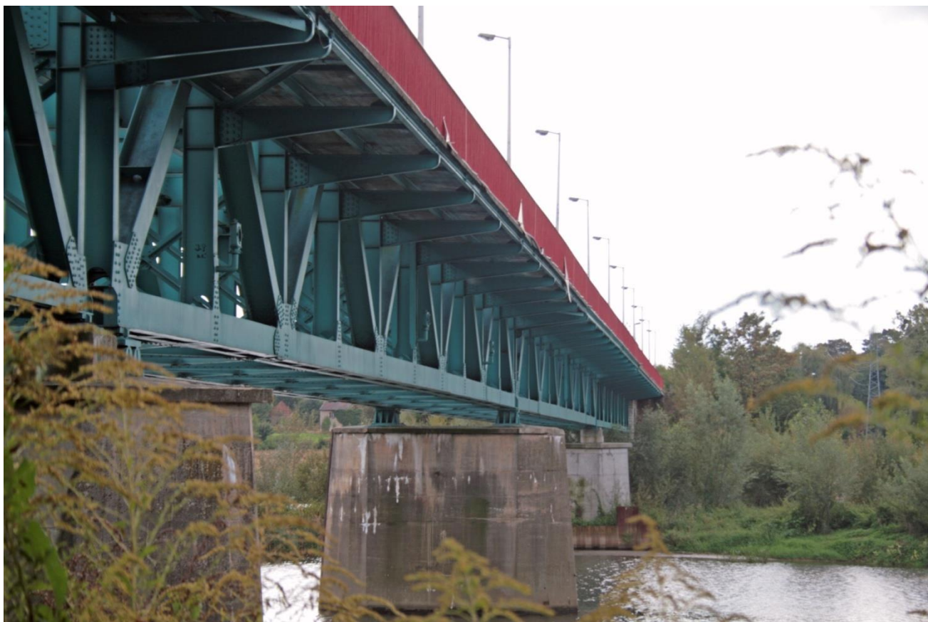
Zdjęcie 4. Most w Krapkowicach – stan powłok 7 lat od wymalowania.
