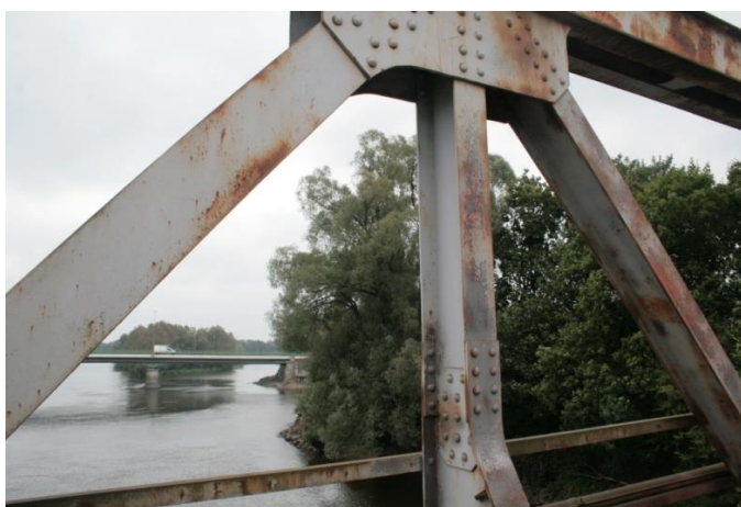
Fig 7. Stan konstrukcji po wyczyszczeniu
