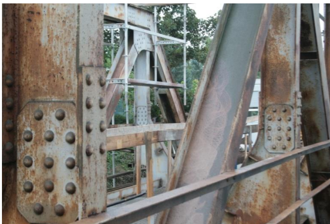
Fig 5. Stan konstrukcji po wyczyszczeniu
