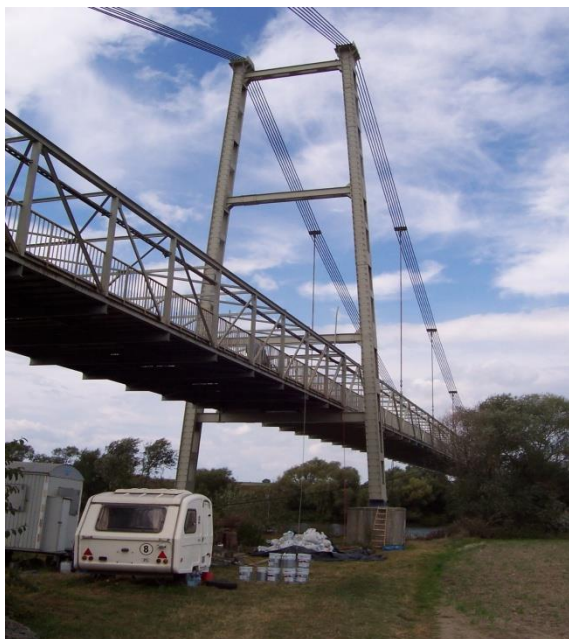
Zdjęcie 2. Most w trakcie malowania
