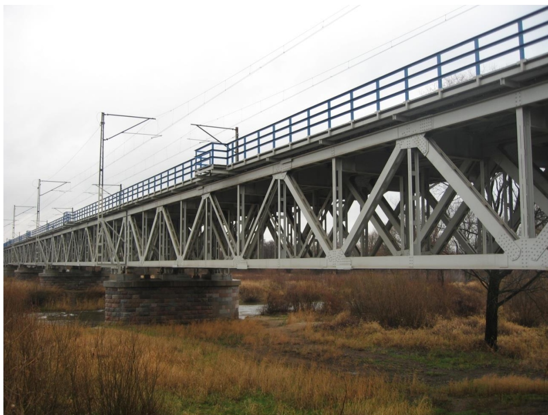
Zdjęcie 1. Przegląd powłok - 2 lata eksploatacji.
