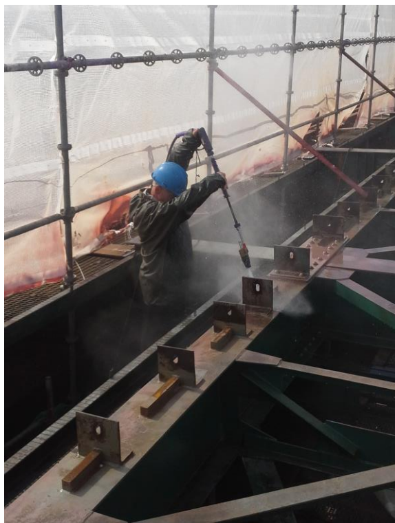
Zdj. 1 konstrukcja w czasie czyszczenia wodą po wysokim ciśnieniu
