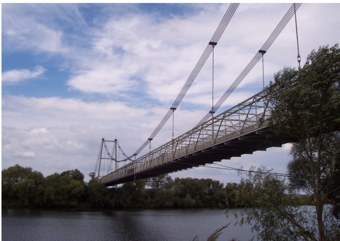
Zdjęcie 4. Widok końcowy mostu po wymalowaniu.
