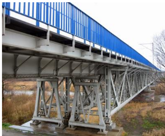
Zdjęcie 6. Stan konstrukcji 2 lata od wymalowania
