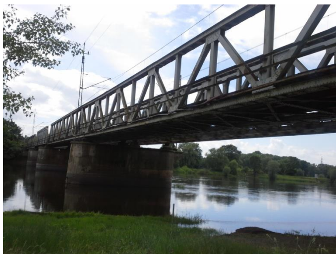
Fig 1. Oryginalny stan konstrukcji
