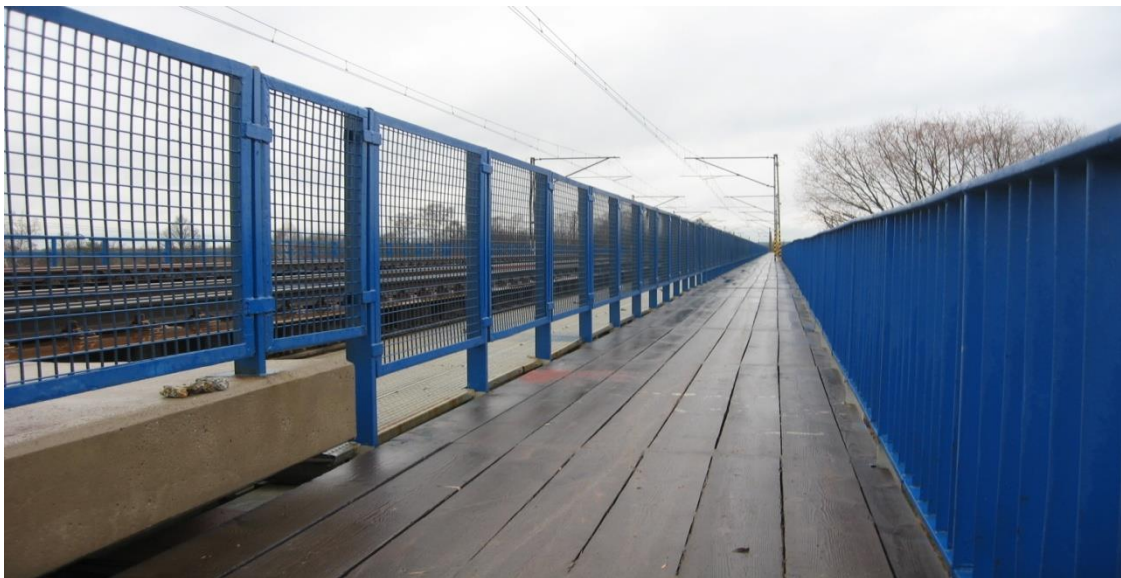
Zdjęcie 4. Most kolejowy - kładka
