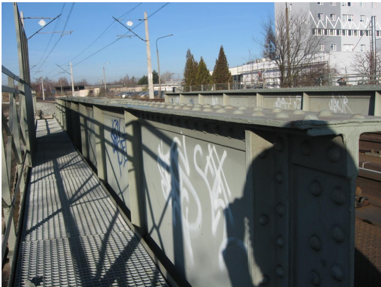
Zdjęcie 3. Most kolejowy Opole ul. Głogowska – kładka – stan powłok 8 lat od aplikacji
