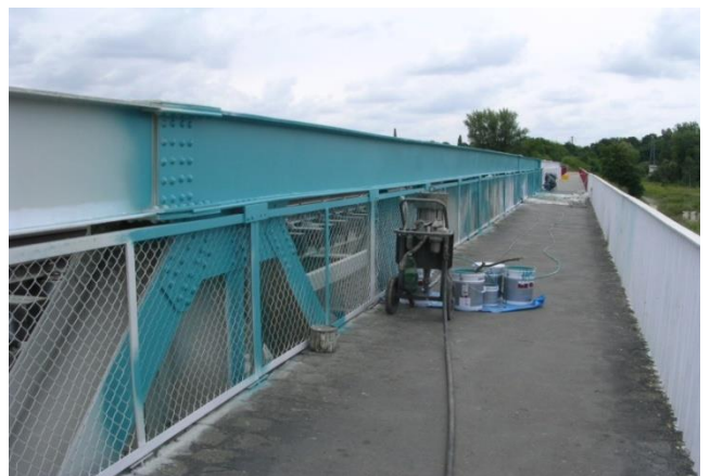
Zdjęcie 2. Most w Krapkowicach w trakcie malowania.
