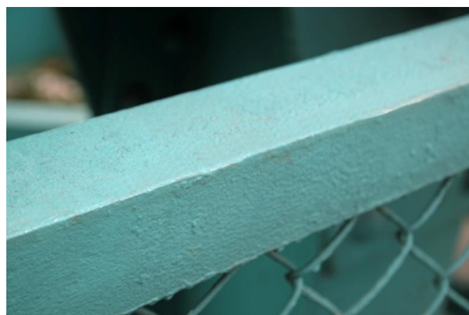
Zdjęcie 6. Most w Krapkowicach – stan powłok 7 lat od wymalowania.
