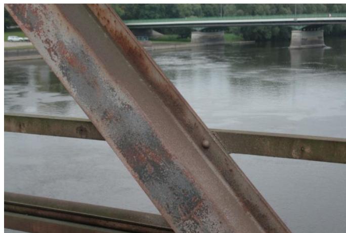
Fig 6. Stan konstrukcji po wyczyszczeniu
