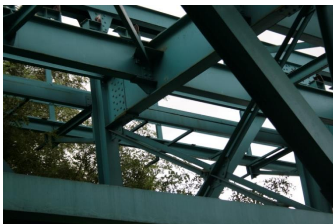
Zdjęcie 5. Most w Krapkowicach – stan powłok 7 lat od wymalowania.
