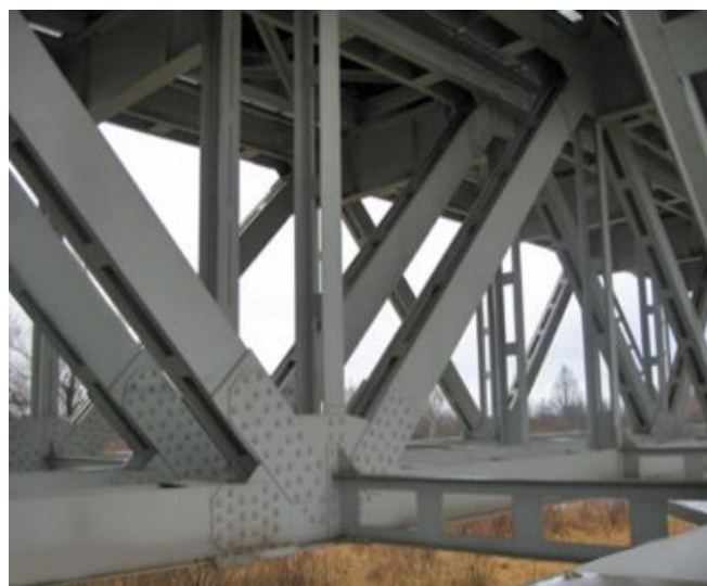
Zdjęcie 8. Stan konstrukcji 2 lata od wymalowania
