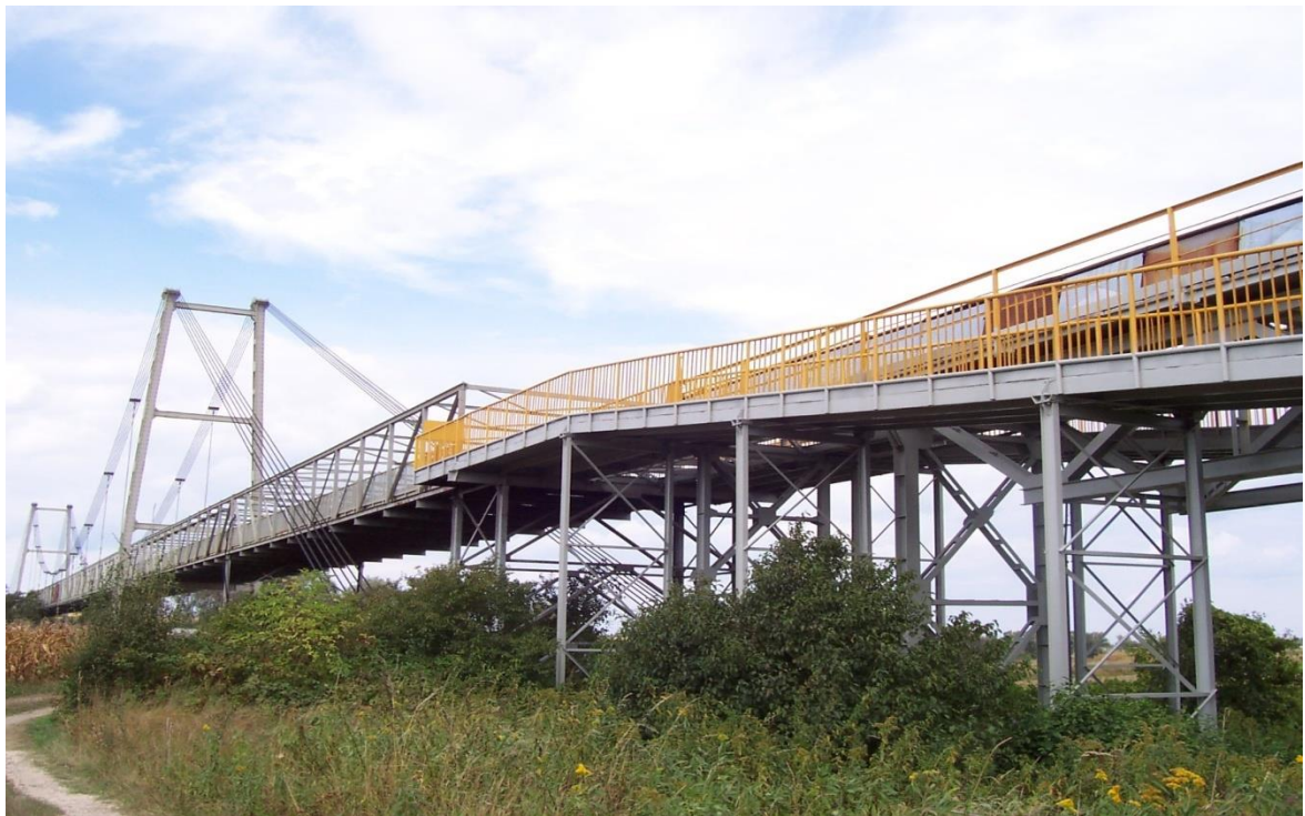
Zdjęcie 1. Galeria tařmociągu w trakcie malowania.
