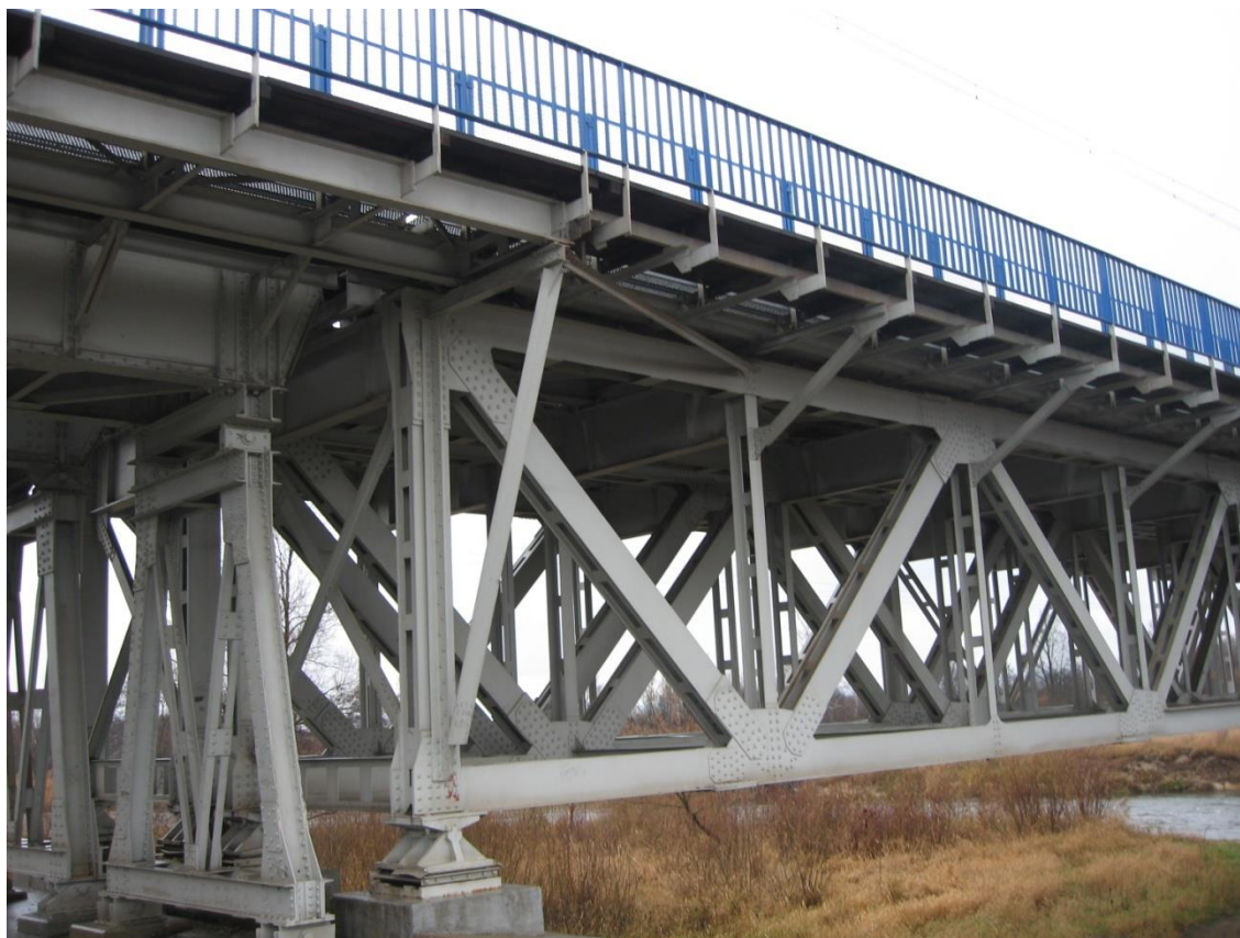
Zdjęcie 2. Przegląd powłok - 2 lata eksploatacji.
