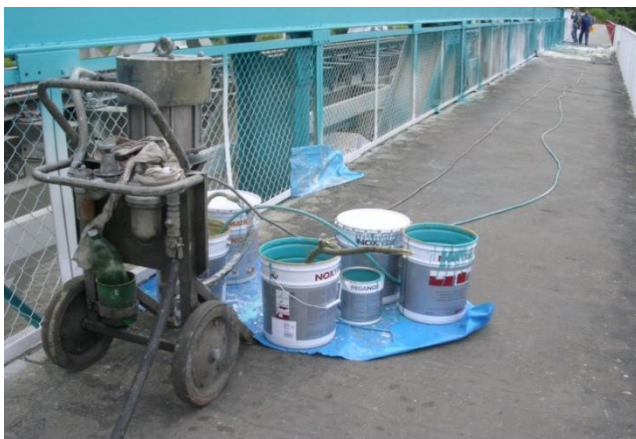
Zdjęcie 1. Most w Krapkowicach w trakcie malowania.
